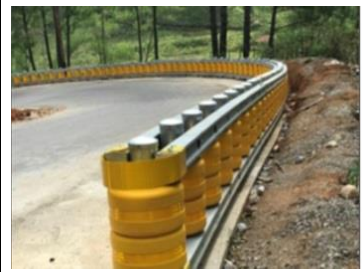
Guardrail Dan Rolling Guardrail/Barrier sepanjang 82 M Pada Lintasan Lokop - Gayo Lues dan Lintas Pining - Blangkejeren
