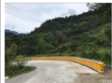
Guardrail Dan Rolling Guardrail/Barrier sepanjang 80 M Pada Lintasan Gayo Lues - Babah Rot
