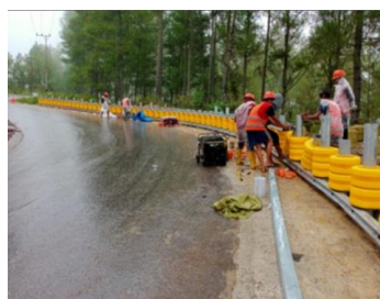
Guardrail Dan Rolling Guardrail/Barrier sepanjang 82 M Pada Lintasan Lokop - Gayo Lues dan Lintas Pining - Blangkejeren
