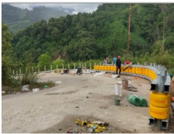
Guardrail Dan Rolling Guardrail/Barrier sepanjang 80 M Pada Lintasan Gayo Lues - Babah Rot
