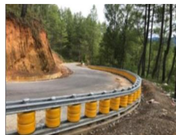
Guardrail Dan Rolling Guardrail/Barrier sepanjang 82 M Pada Lintasan Lokop - Gayo Lues dan Lintas Pining - Blangkejeren
