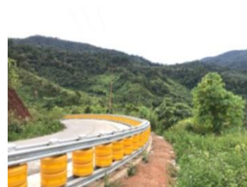
Guardrail Dan Rolling Guardrail/Barrier sepanjang 80 M Pada Lintasan Gayo Lues - Babah Rot
